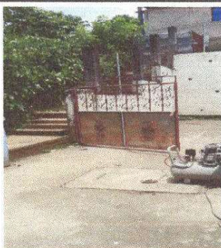
Foto No. 3 Mantenimiento de portones. Cambio de porton.
