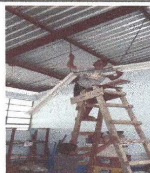
Foto No. 4 Reparacion de sistema electrico. Cambio de bases de lamparas por plafoneras y focos ahorradores.
