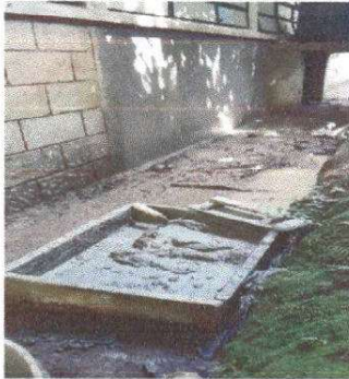
Foto No. 7 Reparacion de repello y cernido de pared. Repello de muro.
