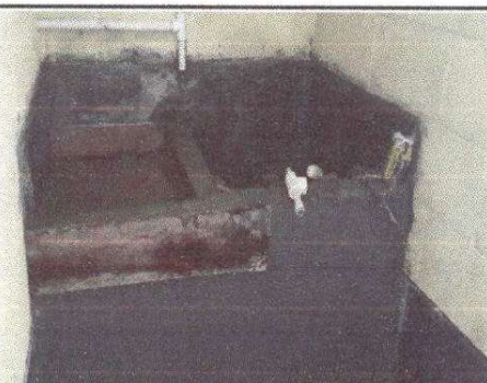
Foto No. 12 Servicios sanitarios. Sustitucion de pila.
