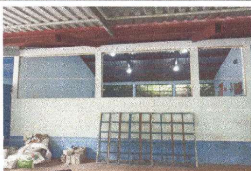
Foto No. 5 Ventanales. Cambio de vidrios por balcones de metal.
