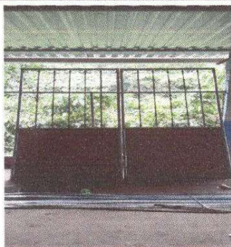
Foto No. 1 Mantenimiento de portones. Cambio de porton de madera por porton de metal.
