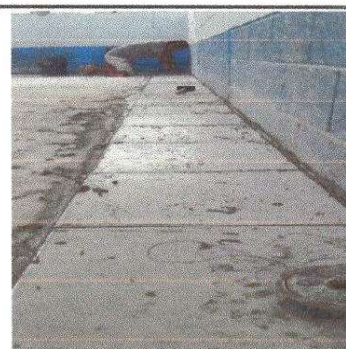
Foto No. 6 Aulas. Cambio de torta de cemento por piso ceramico.
