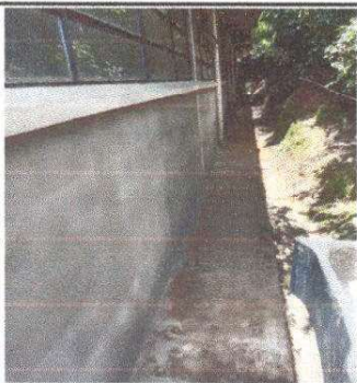
Foto No. 11 Reparacion de repello y cernido de paredes. Repello de muro.
