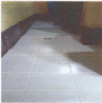
Foto No. 9 Servicios sanitarios. Sustitucion de piso de torta de cemento por piso ceramico.
