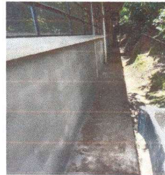
Foto No. 8 Reparacion de repello y cernido de pared. Repello de muro.
